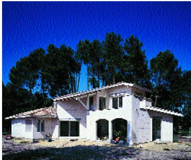
Maison individuelle - Les Arpents de Valérie, Biscarosse Maitre d'œuvre, M. Cathary, Architecte, Biscarosse (40)
